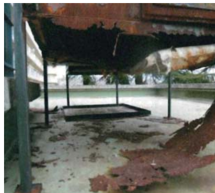
吸排気ファンのドレンパン脱落
