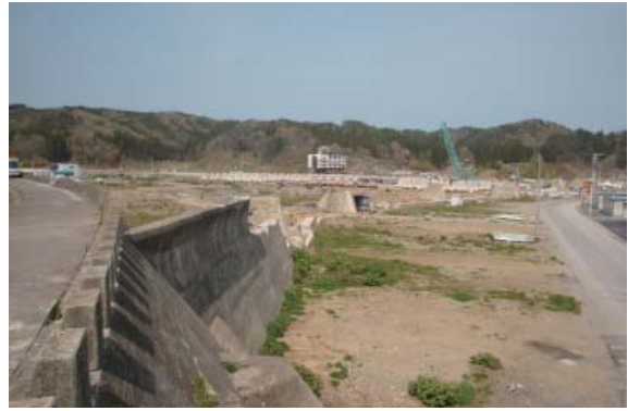
田老地区の「東北の万里の長城」といわれた防潮堤が崩壊している（画面奥の方）
