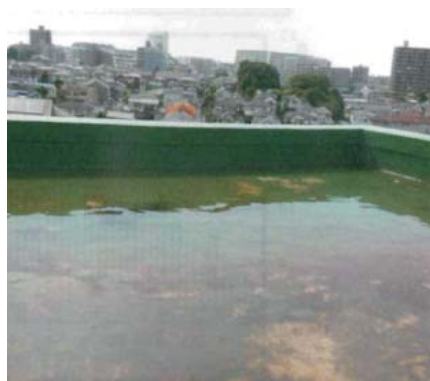
屋上のドレン詰まりによる水溜まり
